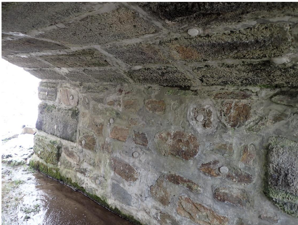
Foto 3: Stopy po injektážních vrtech
