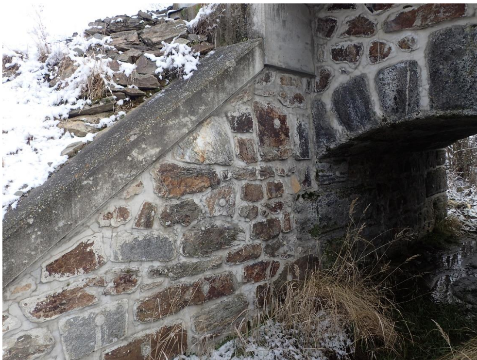
Foto 4: Stopy po injektážních vrtech
